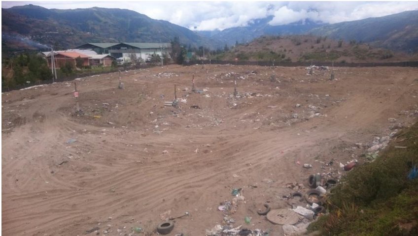
CELDA DE RESIDUOS COMUNES
