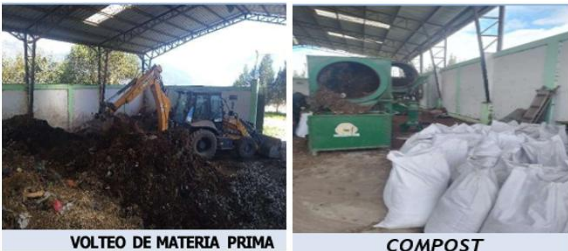
Ilustración 12 Aprovechamiento de Residuos Orgánicos en el CGIRS
