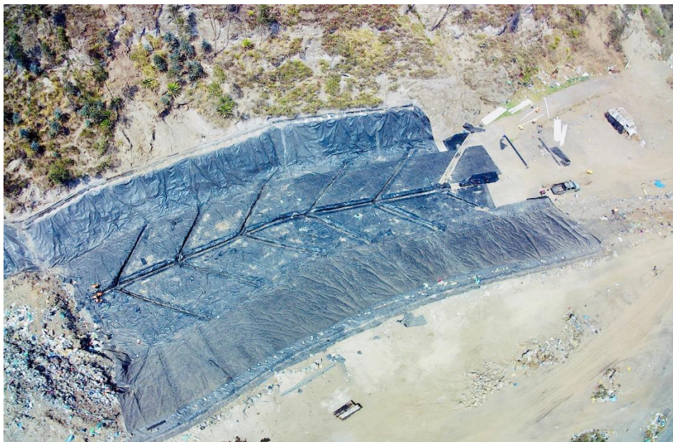
Ilustración 14 Construcción de la Segunda Fase de la Celda Emergente
